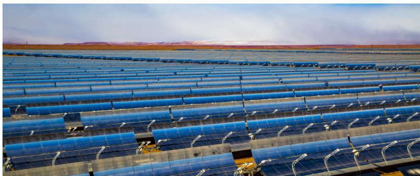
山东电建承建努奥二期光热电站项目
