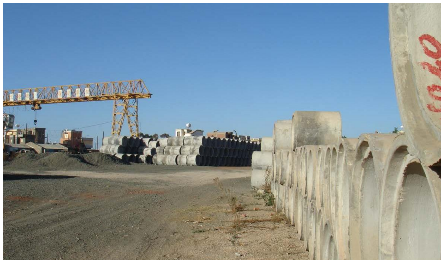
厄特最大中资企业——四川路桥公司施工现场
